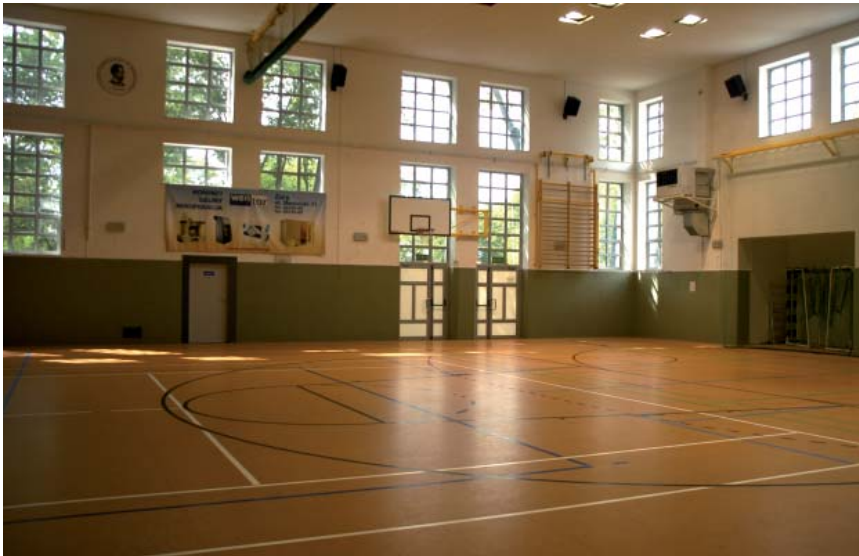
Fot. 2. Robur M z komorą mieszania zainstalowany w hali sportowej
