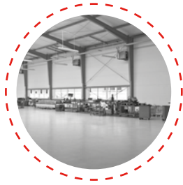
Luchtverwarming en ventilatie
