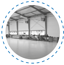
Luchtverwarming en ventilatie
