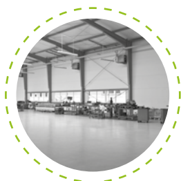
Воздушное отопление и вентиляция
