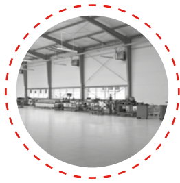
Luchtverwarming en ventilatie
