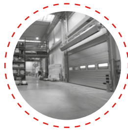
Luchtgordijnen en luchtgordijn met luchtverwarming
