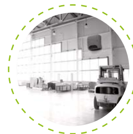
Kanaallose ventilatie-unit met warmteterugwinning.
