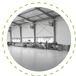
Luchtverwarming en ventilatie.
